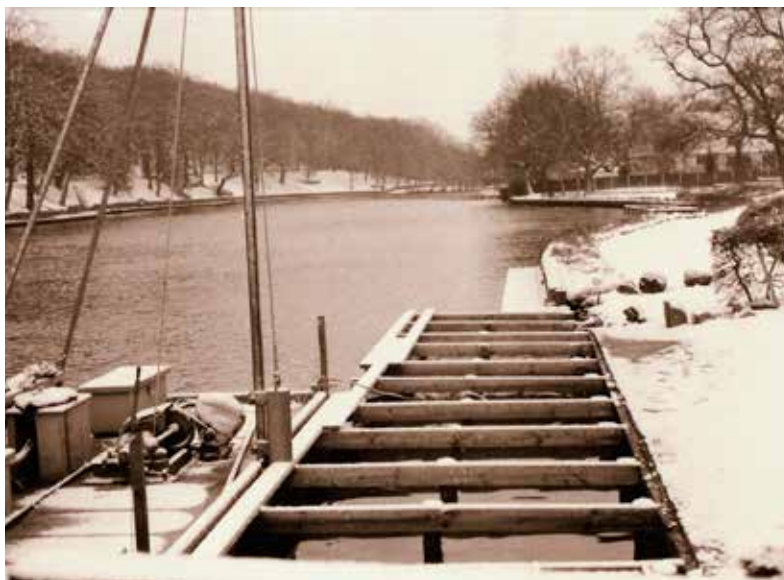
Den nye bådebro under opbygning (1983)
